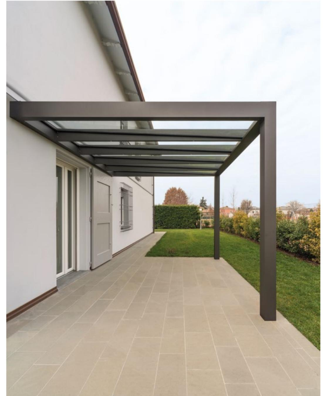
La copertura piana, con travi di soli 200 mm, è realizzata con lastre di vetro la cui inclinazione favorisce un'ottimale raccolta delle acque piovane nella grondaia frontale e lo scarico all'interno delle colonne. Alluver è disponibile sia nella versione addossata a parete che autoportante.
